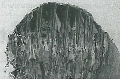
So sieht es aus, wenn zu viele Feuchttücher im Abwasser schwimmen: Unser Bild zeigt das Gitter beim Überlauf des Regenüberlaufbeckens „Große Breite“ Geisingen.
